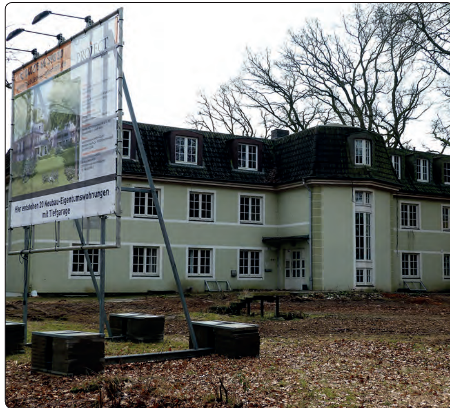
Auch der sogenannte Neubau von 1990 wird abgerissen.
