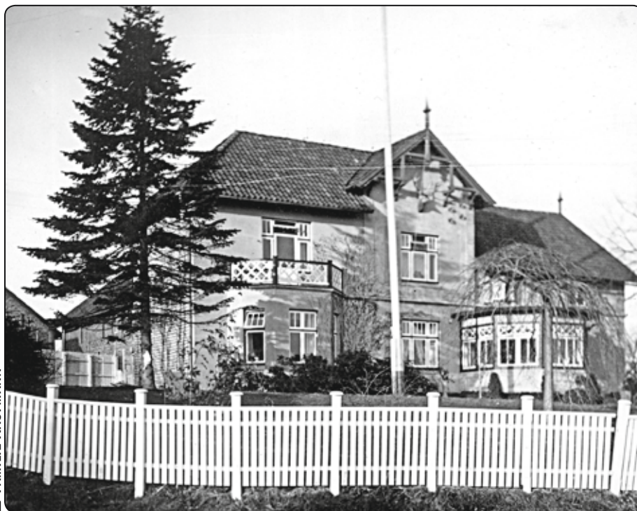
Der Ziegelhof in Duvenstedt um 1930
